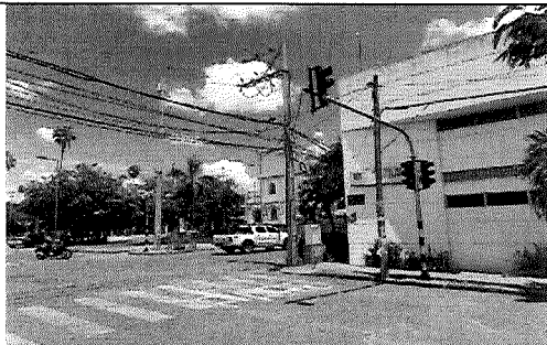
1. Vista general de semáforos
