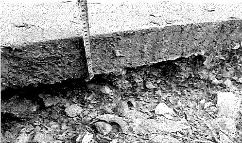
3. Espesor de placa 0,15 m
