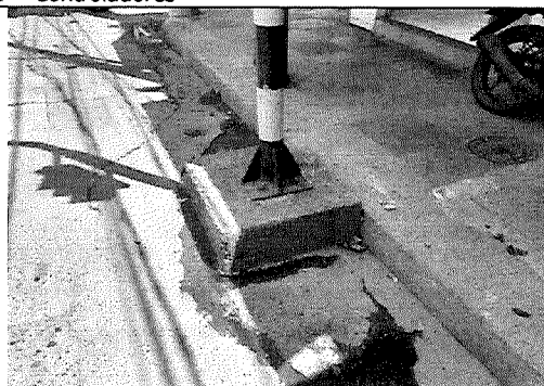
4. Cimentación de semáforos
